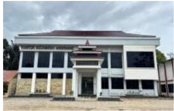
Pekerjaan Pembangunan Kantor Kecamatan Angkinang (Lanjutan)
