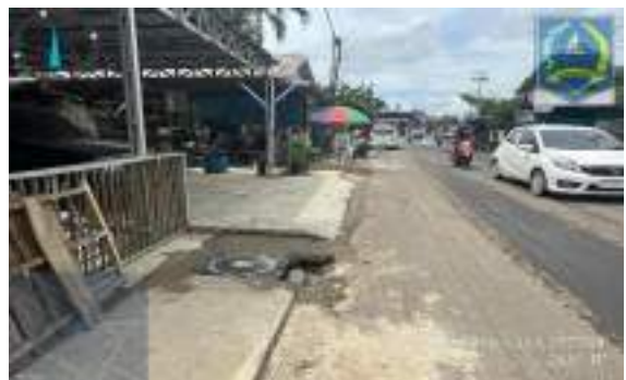
Pekerjaan Pembangunan Saluran Drainase Jl. Brigjend H. Hasan Basry
