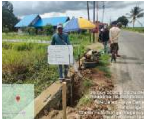
Pekerjaan Perluasan SPAM Jaringan Perpipaan Desa Amawang Kiri Muka Kec. Kandangan (Lanjutan)
