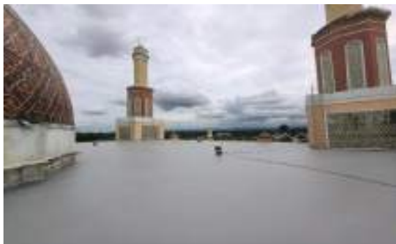
Pekerjaan Peningkatan Struktur Mesjid Nurul Hidayah
