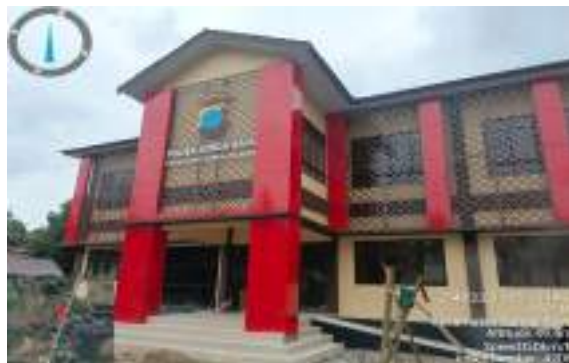
Pekerjaan Rehabilitasi Polsek Sungai Raya
