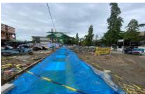
Rehabilitasi Saluran Drainase Jl. Pangeran Antasari
