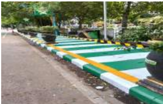
Pekerjaan Operasi dan Pemeliharaan Sistem Drainase Trotoar dan Pedestrian Kel. Kandangan Kota
