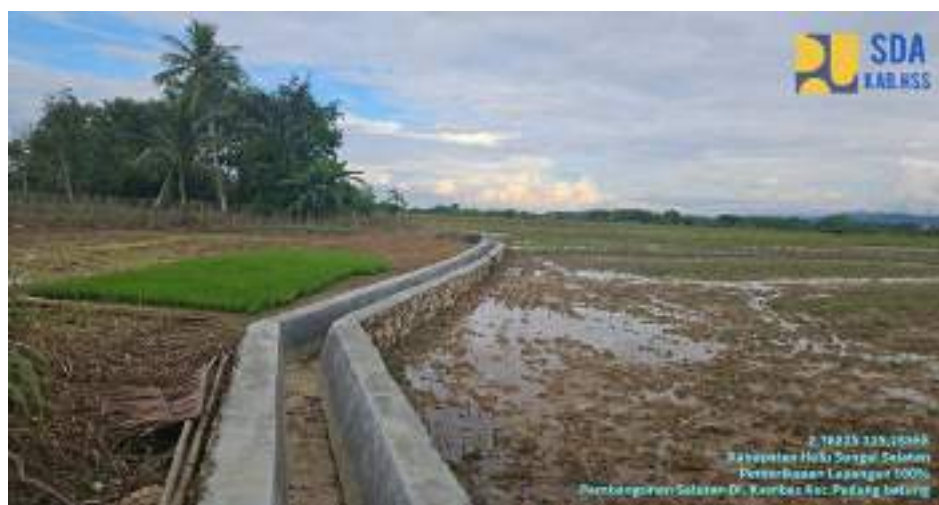
Pembangunan Jaringan Irigasi Permukaan
