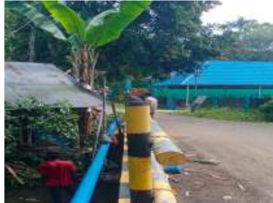
Pekerjaan Perluasan SPAM Jaringan Perpipaan Desa Hariti Kec. Sungai Raya
