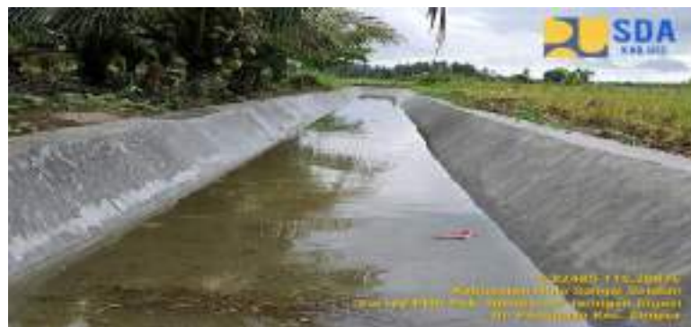
Rehabilitasi Jaringan Irigasi DI. Pamujaan
