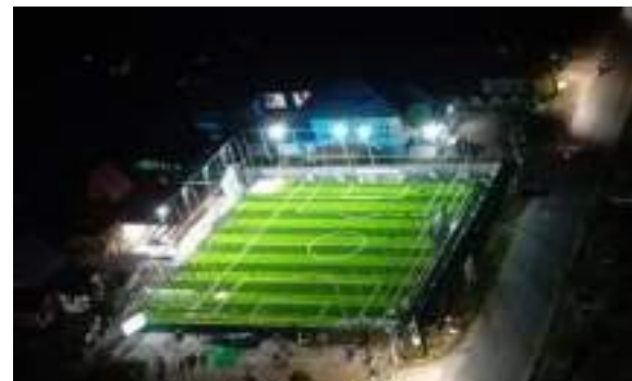
Pekerjaan Pembangunan Mini Soccer Kec. Sungai Raya
