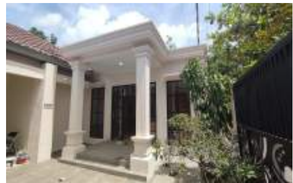
Pekerjaan Rehabilitasi Rumah Jabatan Kejari (Lanjutan)
