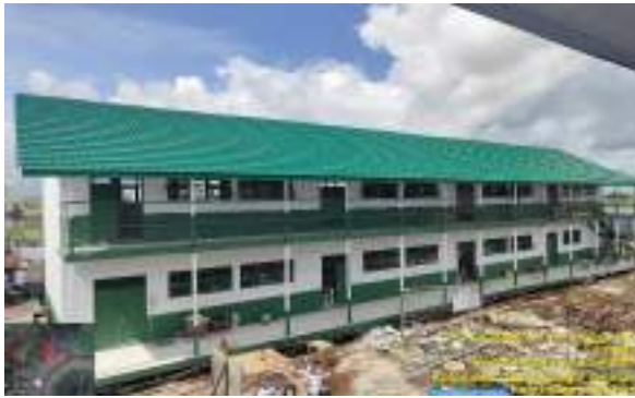
Pekerjaan Pembangunan Gedung Sekolah SD Negeri 1 Samuda
