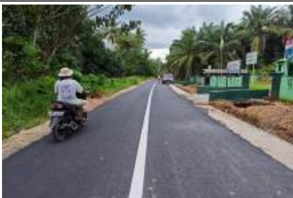
Rehabilitasi Ruas Jalan Tabihi - Telaga Langsat Kec. Telaga Langsat
