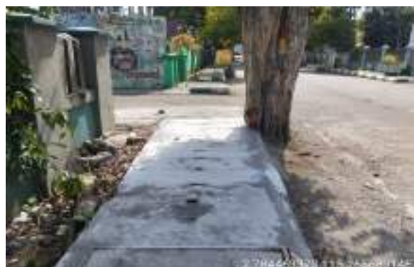
Operasi dan Pemeliharaan Sistem Drainase Jalan Pemuda dan Sistem 6
