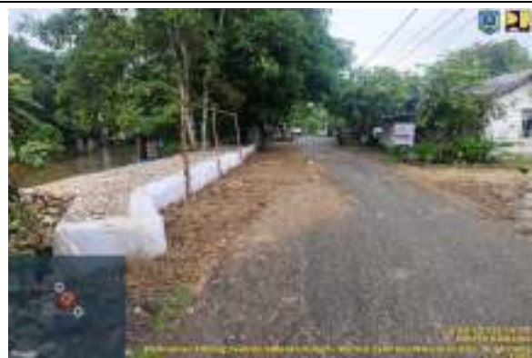
Perkuatan Tebing Ruas Jalan Taniran Selatan Kubah - Buntut Wawaran Kec. Angkinang
