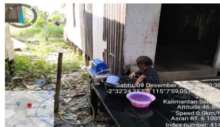
Pemasangan Sambungan Rumah (SR)
