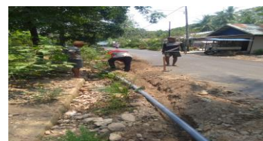
Pemasangan Jaringan Perpipaan
