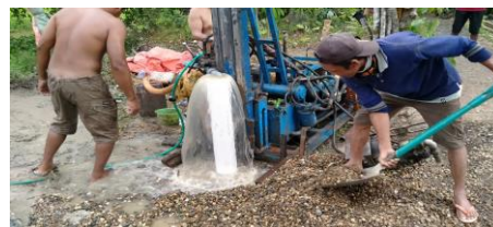
Pengerjaan Sumur Bor
