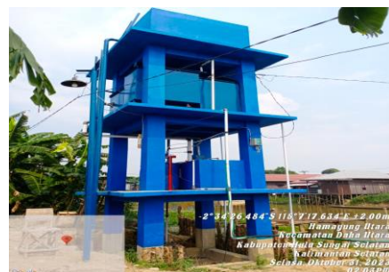
Pembangunan SPAM Perdesaan berupa bangunan menara air
