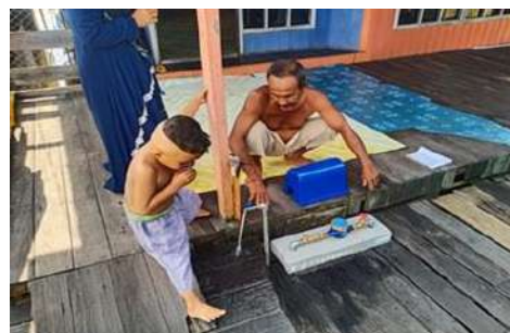
Pemasangan Sambungan Rumah (SR)
