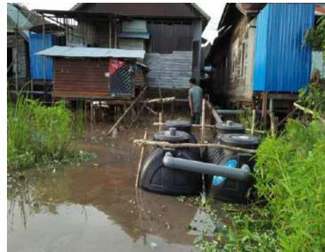
Pembangunan IPALD Desa Karang Paci
