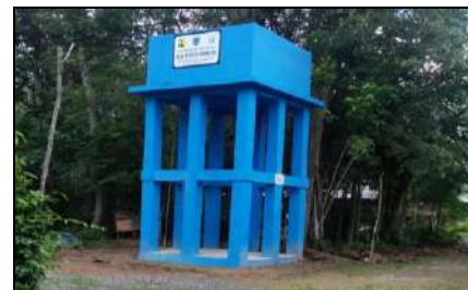
Pembangunan SPAM Perdesaan berupa bangunan menara air
