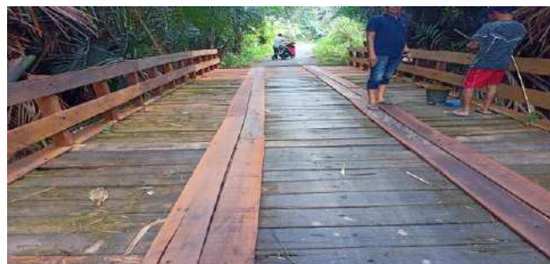
Pekerjaan Pemeliharaan Rutin Jembatan Pabahanan Desa Sirih Hulu Kec.
