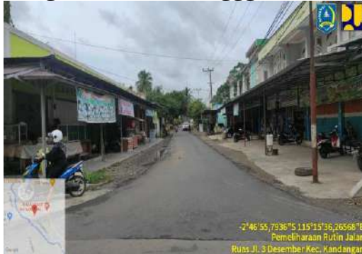
Pekerjaan Pemeliharaan Rutin Jalan Ruas Budi Bakti - Tiga Desember Kec. Kandangan
