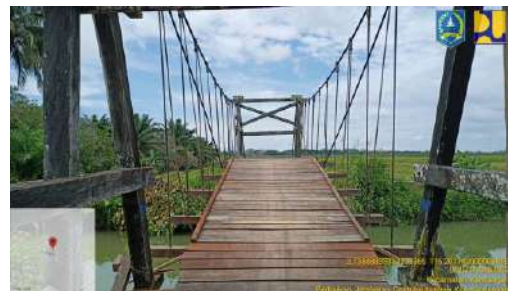
Perbaikan Jembatan Gantung Lungau Kec. Kandangan
