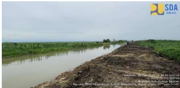
Normalisasi/ Restorasi Sungai Bahalayang Desa Lungau Kec.Kandangan
