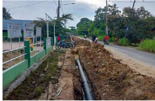
Pemasangan Jaringan Perpipaan
