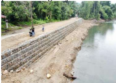
Pekerjaan Penanganan Longsor di Desa Hulu Banyu Kec. Loksado
