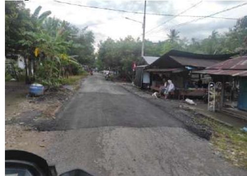
Pekerjaan Pemeliharaan Rutin Jalan Ruas Tabihi - Telaga Langsat
