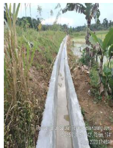
Pembangunan Saluran tersier di
