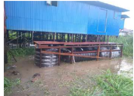
Pembangunan SPALD BBM
