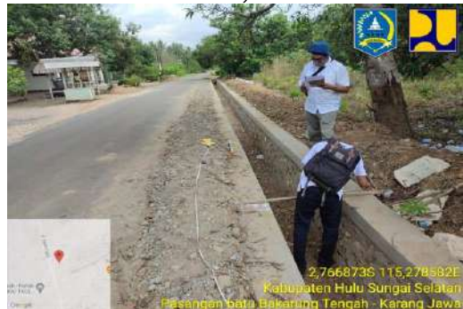
Perbaikan Saluran Drainase Jl. Bakarung Tengah - Karang Jawa
