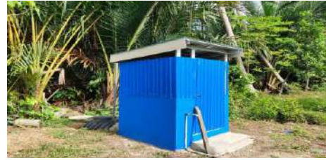
Septik tank Desa Panjampang Bahagia
