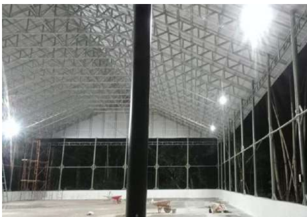
Pembangunan Lapangan football Kec. Loksado
